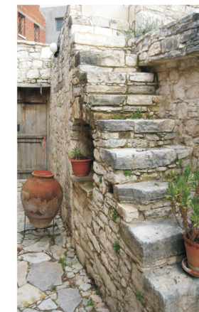
εσωτερική σκάλα που οδηγεί στο δώμα μιας παραδοσιακής κατοικίας
